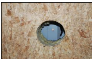
Ett 135 mm hål borras i väggen
