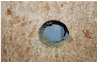
Seinään porataan 135 mm reikä
