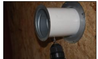
porataan reiät ja ruuvataan kiinni.
