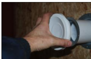
ja tuloventtiili asennetaan.
